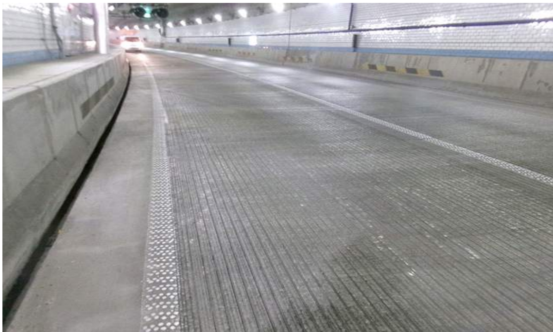
BOX구간 포장 전경
