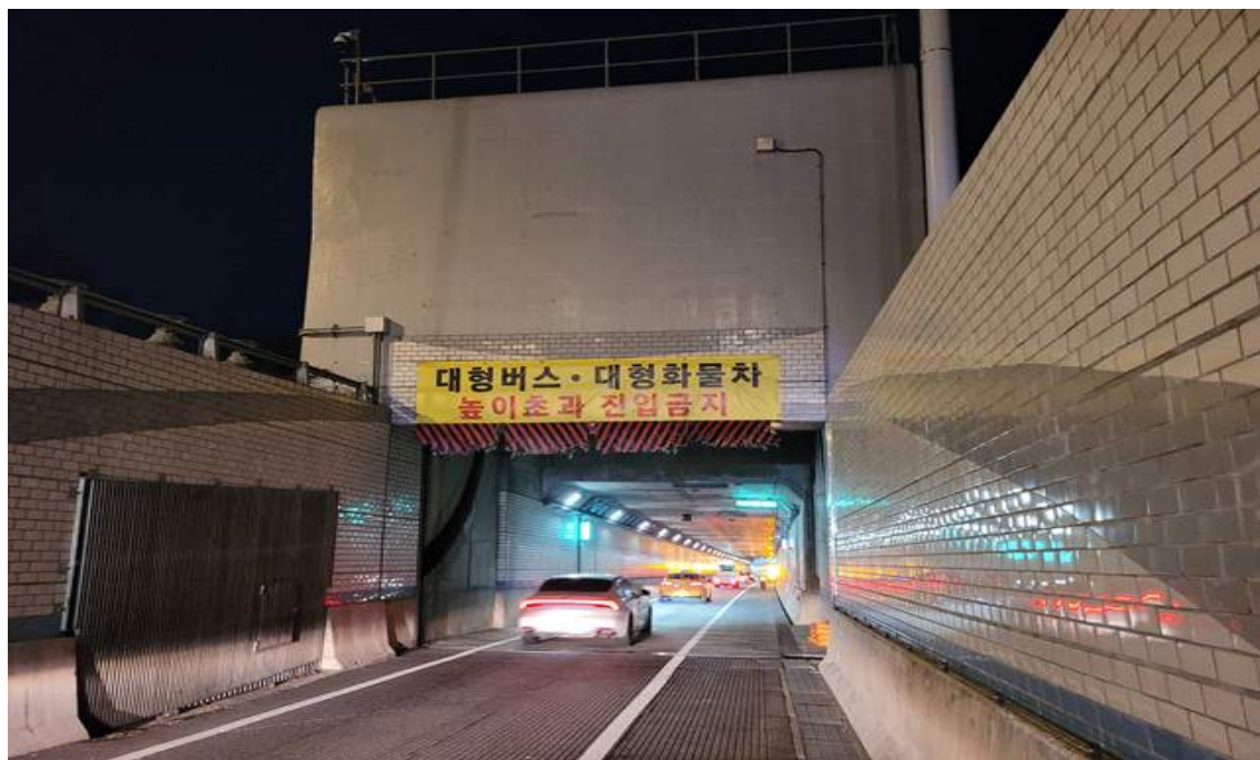
RAMP-D 갭문 진입부 전경
