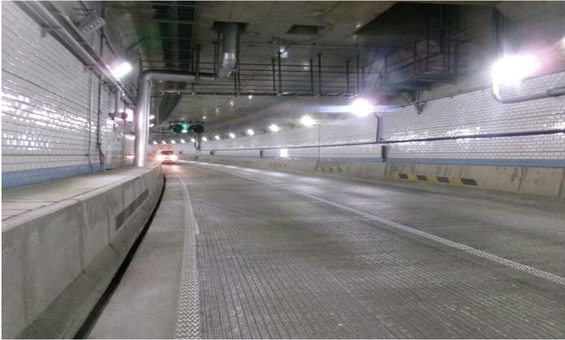
BOX구간 내부 전경
